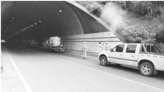
9 月 11 日起，新城养护站对辖区内黄杨尖隧道、铁火尖隧道进行墙面及标线清洗工作。路政人员在清洗路段规范设置安全警示牌，进行交通管制。养护人员用水枪和滚刷对墙面进行多次清洗，目前两座隧道已全部清洗完毕。
